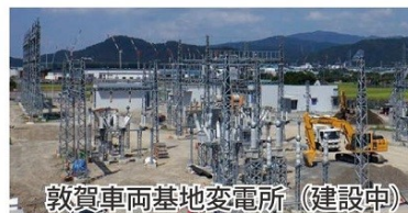
敦賀車両基地変電所 (建設中) 電力会社から受けた電源を変電所などに設置した変圧器により列車運行に必要な運転用電力へ変換し、新幹線に電力を供給する設備です。敦賀市内には、葉原地区に本線走行用の新敦賀変電所、坂下地区に車両基地走行用の敦賀車両基地変電所を設置します。
